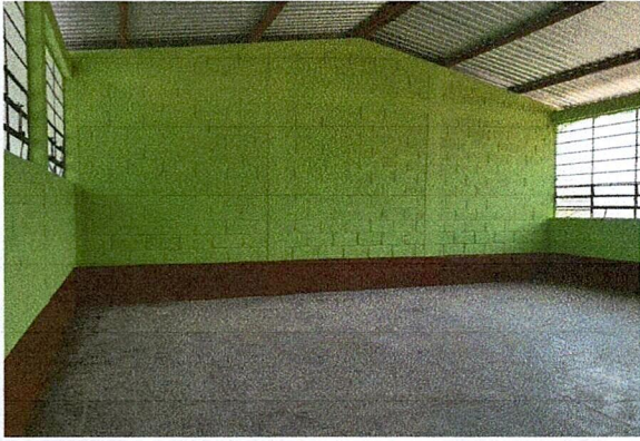
Foto 1: Mejoramiento de pintura interior y exterior
