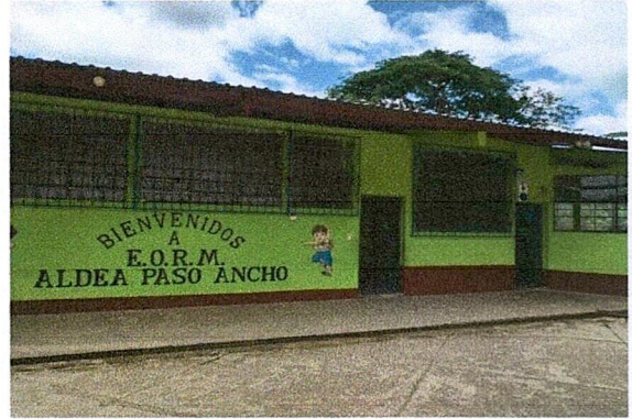
Foto 2: Mejoramiento de pintura interior y exterior
